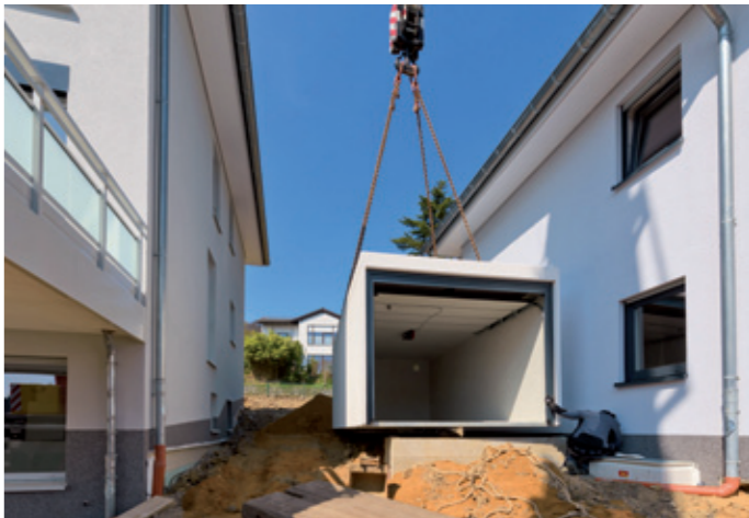
Bei einer beengten Baustelle kann eine Garage mit einem Mobilkran auf die vorbereiteten Fundamente gesetzt werden.
