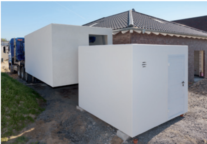
Die Garage wird vor dem Anbau abgesetzt.
