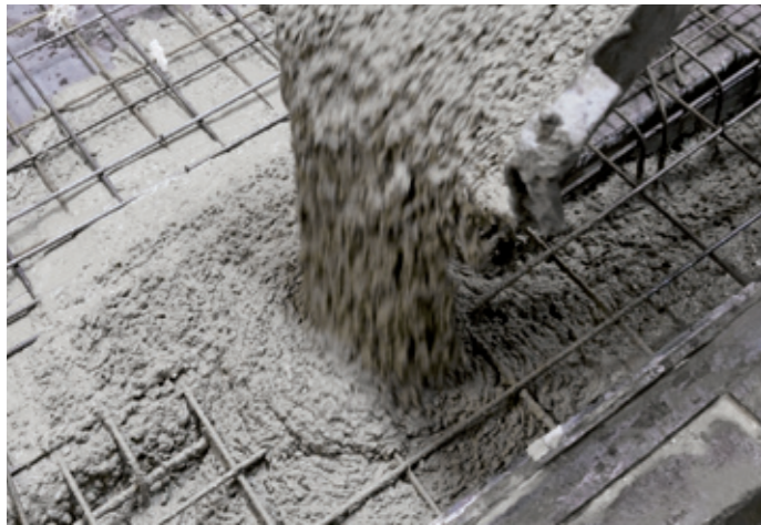
Beton und Stahl ergänzen hervorragend Ihre Eigenschaften. Beton nimmt auftretende Druck- und Stahl Zugkräfte auf.
