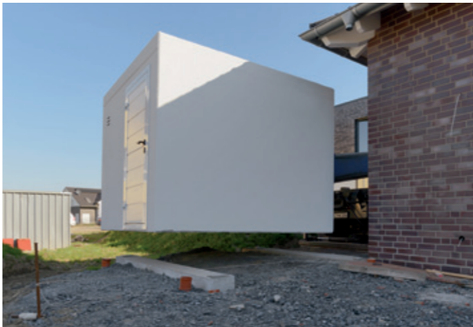
Der Unterbau des Stellplatzes ist optimal mit Streifenfundamenten und mit einem Schnurgerüst vorbereitet.
