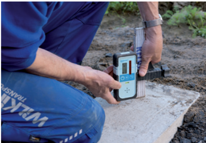
Vor dem Montagebeginn einer Garagen-Anbau-Kombination prüfen unsere Monteure den Aufstellplatz
